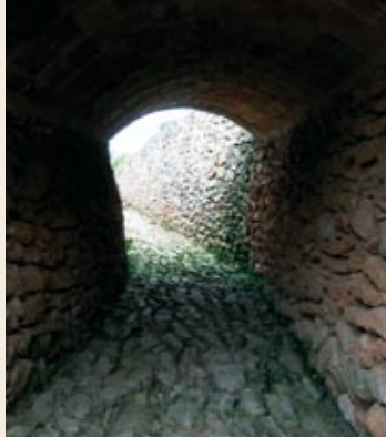
Zanja de desagüe del camino
